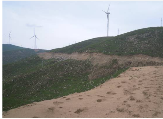
风机及检修道路
