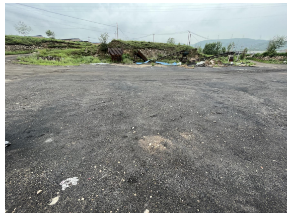
扩建工程场地
