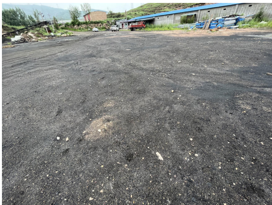
扩建工程场地
